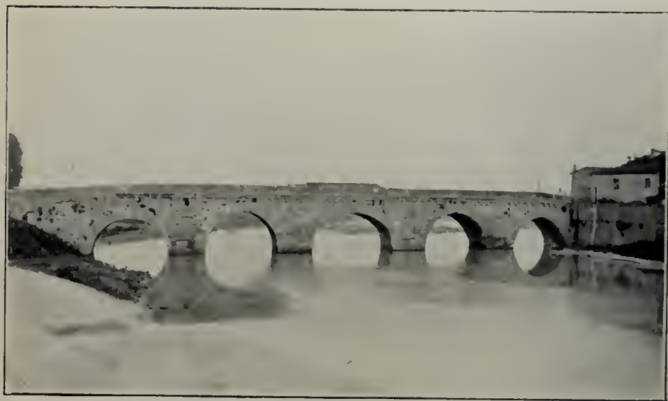
Fig. 36. ROMAN BRIDGE AT RIMINI. 22 A. D.
